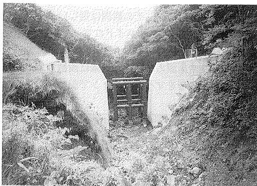
写真-2 鋼管製土石流捕捉工(砂防堰堤) (白浜川, 北海道)
