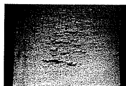
図-12 圧縮側に生じたき裂
