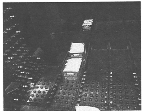
(c) 除湿剤の設置状況
