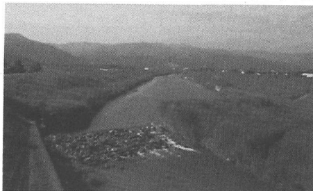
写真-1 捨石堰の例 (城原川)
