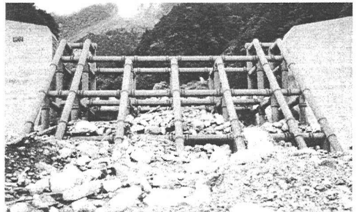
写真-1 オープン型鋼製砂防堰堤の一例
