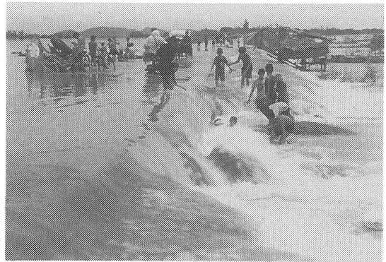
写真-3 6号線交差点手前での6A号線盛土の越流
