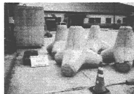
写真 - 5 消波ブロック養生状況
