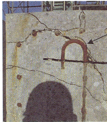
写真-1 付着破壊と見られる L-1 試験体のせん断補強筋端部状況
