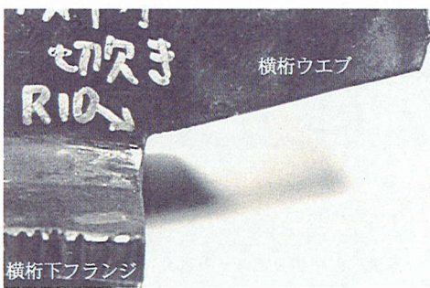
写真-12 桁端切欠部形状
