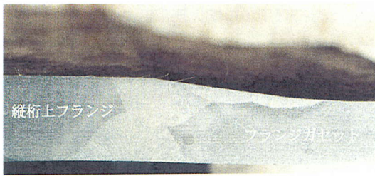
写真-9 縦桁面内ガセット溶接部マクロ試験結果
