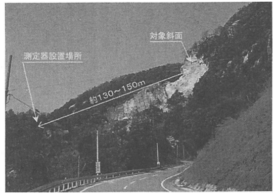
写真-7 測定器と対象斜面
