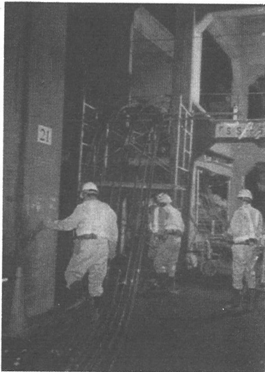
写真-3 主鋼材設置状況
