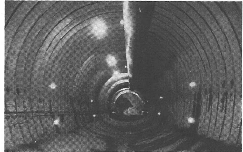
写真-3 二次支保工完了状況
