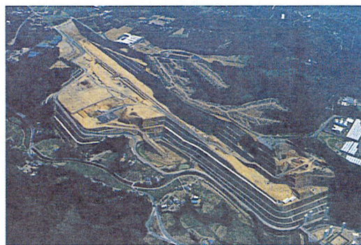
写真-1 厚層締固めによる盛土完了状況 (第二東名 浜松・浜北 SA (仮称))
