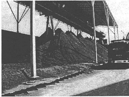
写真-4 一次処理土ストック状況
