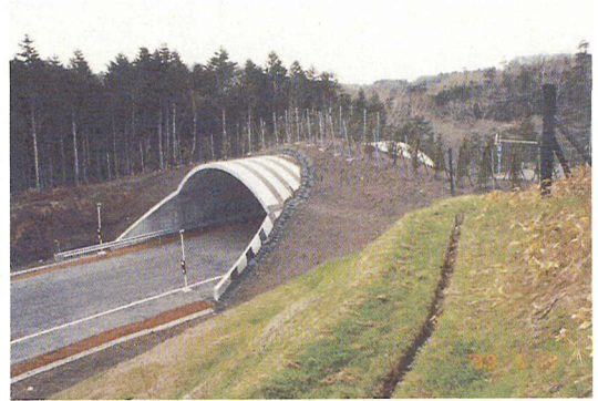
写真-2 オーバーブリッジの建設直後の全景
