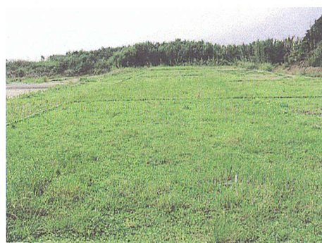
写真-10 イワダレソウ主体, 客土吹付け (6-E)
