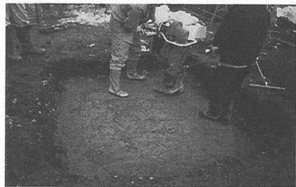
写真-3 埋め戻し施工状況
