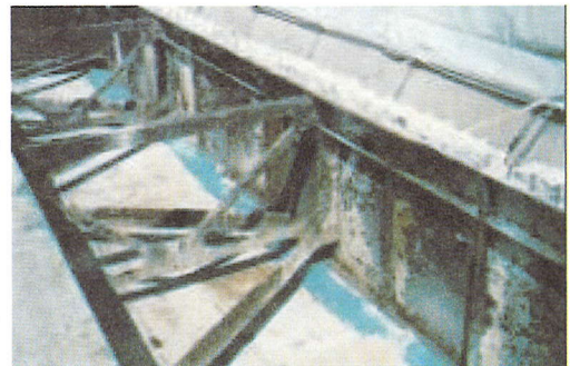
図-2 取り替え前の当該橋梁の状況（床版撤去後）
