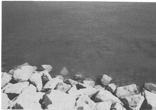
写真-2 打設直後の状況
