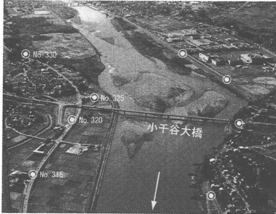
写真-3 No. 320～No. 330 付近の河道内に形成された砂州の状況
