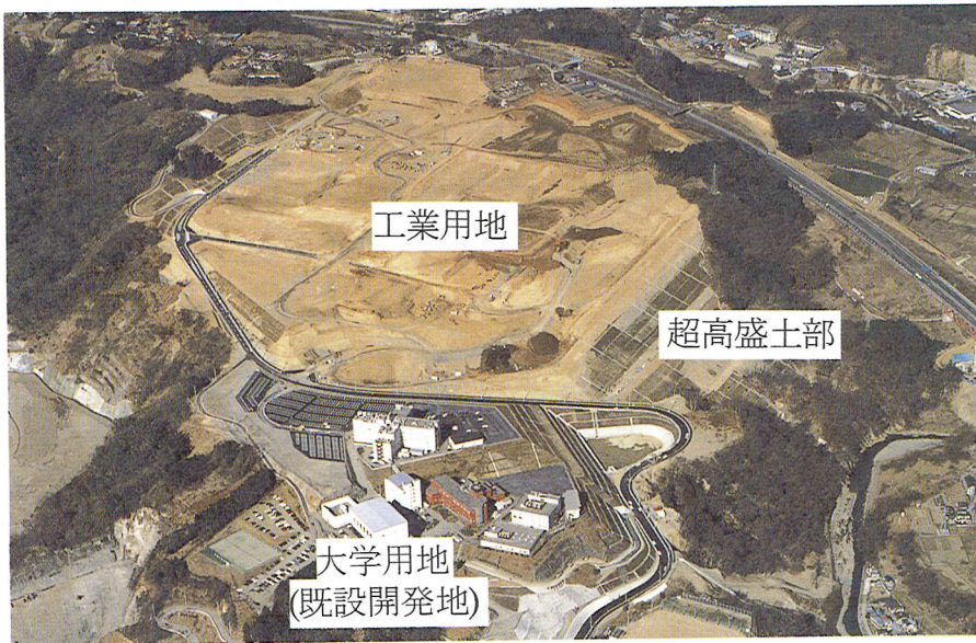
写真-1 造成地全体の施工中の状況
