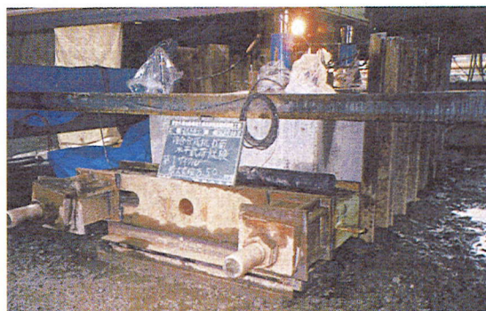
写真-2 水平荷重試験の荷重様子 1)
