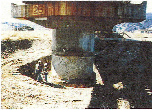
写真-1 洗掘再現試験掘削の状況 (富士川橋りょう第25橋脚)
