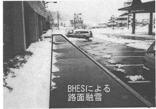
写真-3 冬期における BHES による歩道融雪 (道の駅「八チ北」: 1999年1月8日)
