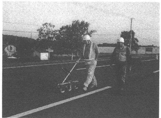
写真-2 Rolling Dipstickによる縦断プロファイルの測定
