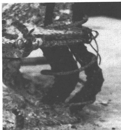
写真-1 DASC供試体における軸方向鉄筋の座屈状況
