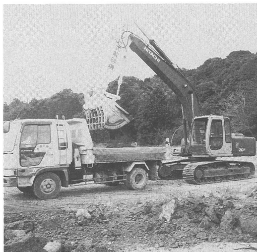
写真-2 初期固化土を解砕中の解砕機
