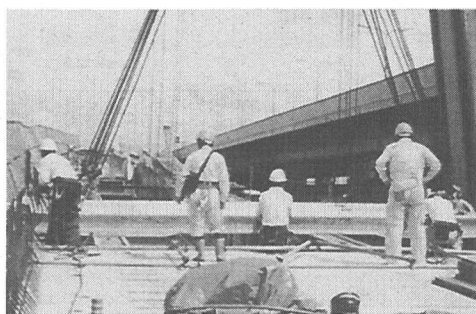
写真-2 プレキャスト床版敷設状況
