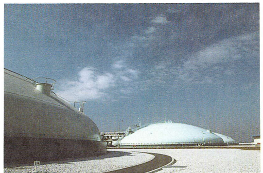
写真-1 13万kl LNG地下タンク(袖ヶ浦基地)
