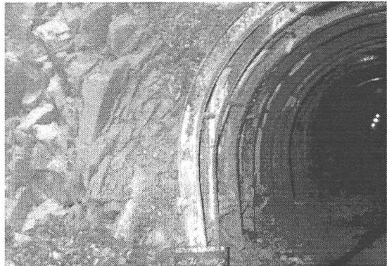
写真-1 掘削面に沿う割れ目
