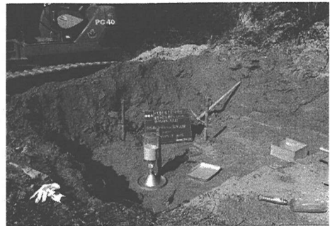
写真-1 砂置換法による密度測定状況
