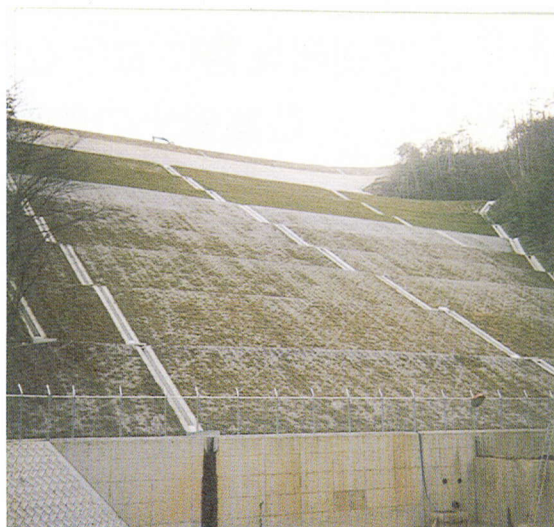
写真一 造成完了時の超高盛土部の全景
