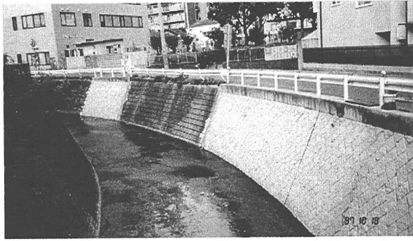
写真-1 石積工を主体とした復旧(天上川)
