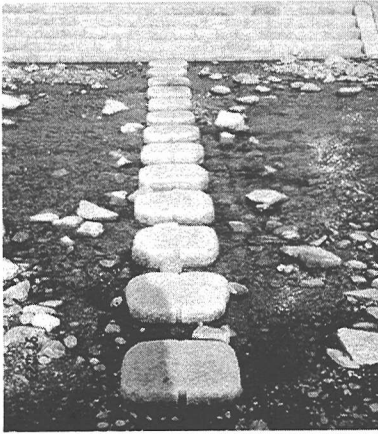
写真-2 渡り石と階段護岸(住吉川)
