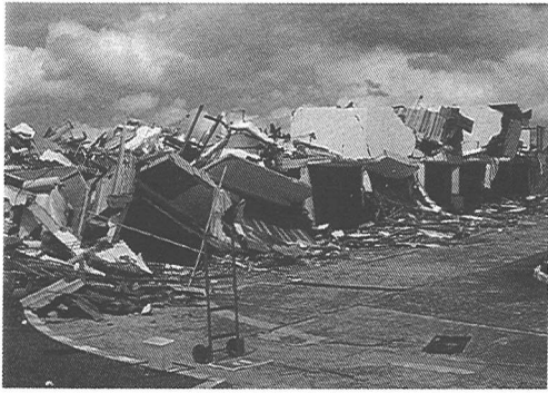
写真-1 竹筋泥壁工法，焼成煉瓦による無補強組積工法による建物(提供 E.Rodriguez grandos)
