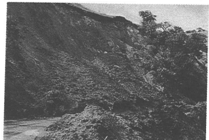
写真-5 斜面崩壊による崩土が道路を覆った現場 (提供:E.Rodriguez grandos)
