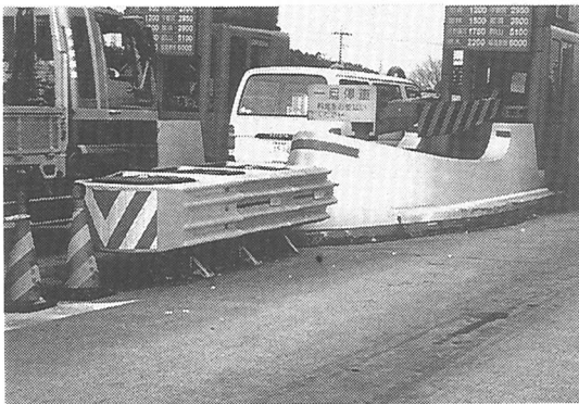
写真-5 緩衝施設の設置状況
