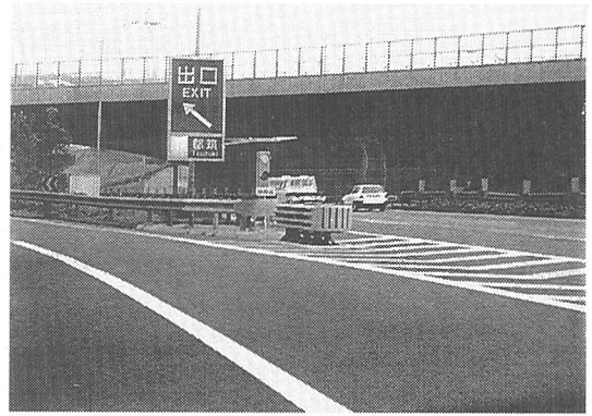
写真-3 都筑ICの分岐ノーズ部
