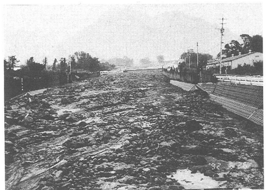
写真-2 1992年6月23日発生の土石流による堆砂状況 (水無川大南橋から上流を望む)
