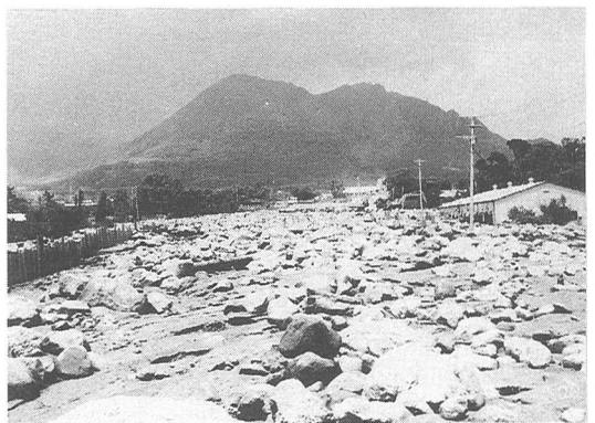
写真-3 1992年8月8日発生の土石流による堆砂状況 (水無川大南橋から上流を望む)
