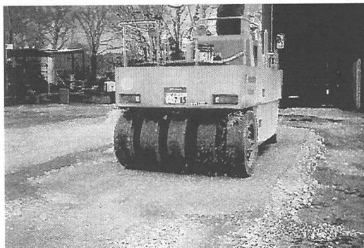
写真-4 試験路盤の転圧
