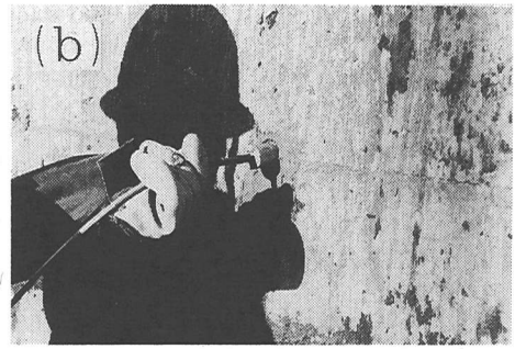
写真-2 AEセンサー設置状況
