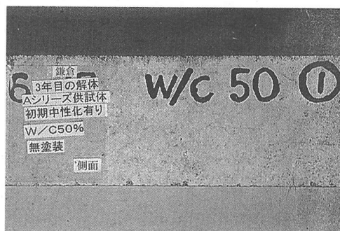
写真-2 鎌倉に3年間暴露したAタイプ供試体の外観 (W/C50%, 初期中性化有りの場合)
