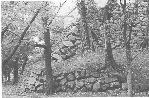
写真-3 岡山城天守台石垣隅角下押え石積み (撮影：田中, 1997)
