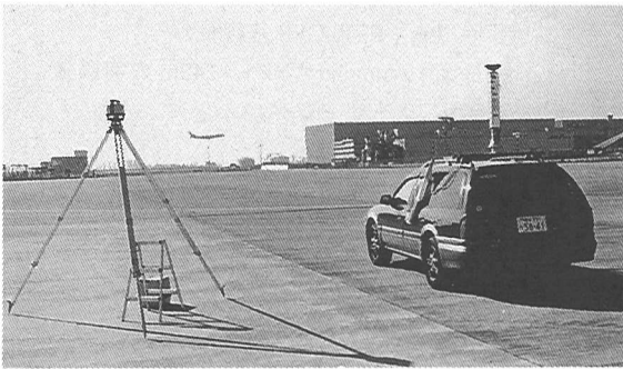
写真一 1 東京国際空港での測量の状況
