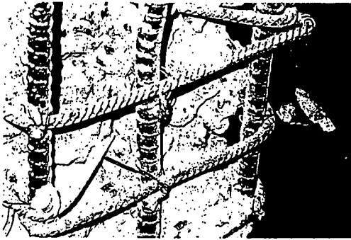
写真-2 帯鉄筋定着部の破壊状況(鋭角フック)
