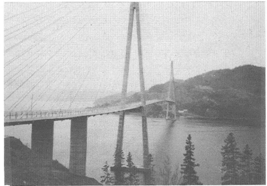
写真-6 スカルンズンド橋
