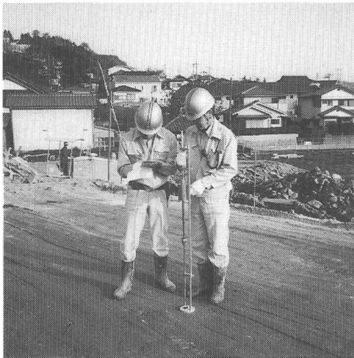
写真-1 改良型コーン貫入試験の実施状況
