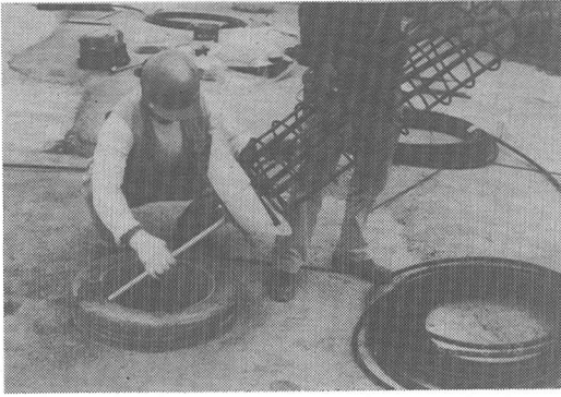
写真-3 杭内部への配管
