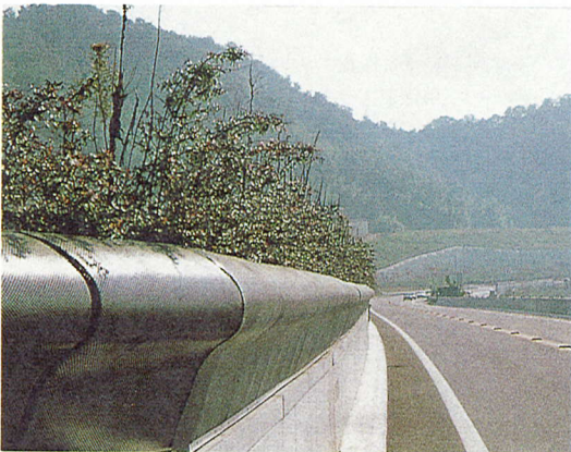
写真-2 緑化型ノイズリテューサーの概観 (近撮)
