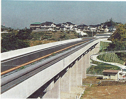
写真-1 緑化型ノイズリテューサー設置道路
