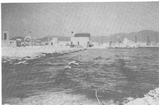
写真-2 岸壁被災状況図
