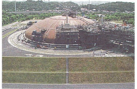
写真-4 知多LNG地下タンク建設状況(H9. 8)
