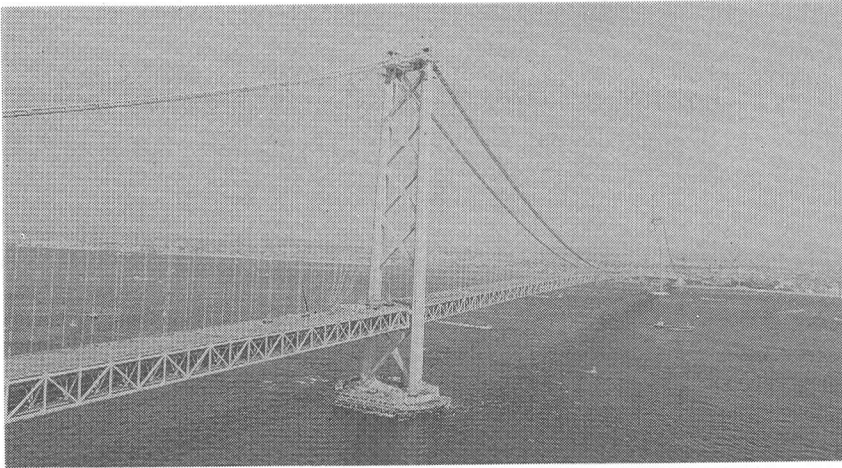
写真-1 明石海峡大橋の状況 (97年10月)
