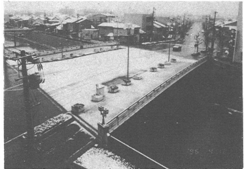
写真-1 鋼床版橋の積雪状況 (96.4.12.6:50)
