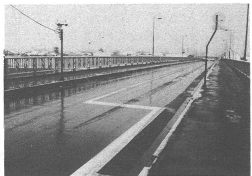
写真-2 コンクリート床版橋の積雪状況 (96.4.12.7:00)
